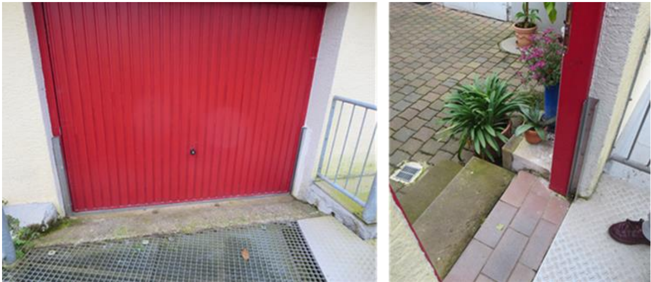
Abb. 19: U-Schienen für Dammbalkenverschlüsse
