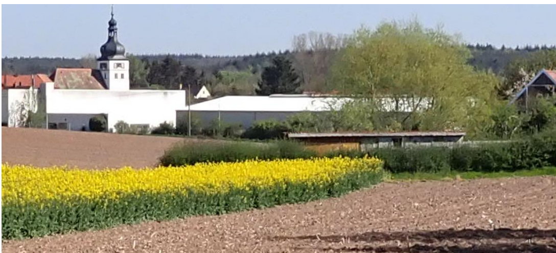
Abb. 75: Überflutungsgefährdete Hallen in der Tiefenlinie
