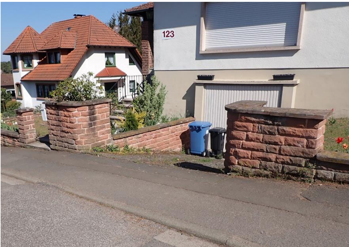
Abb.: 14: Abschüssige Garagenzufahrt
