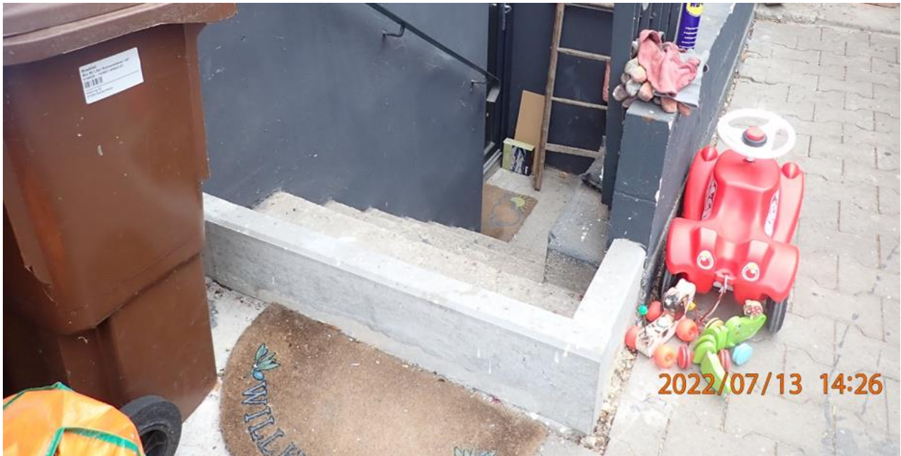
Abb. 18: Beispiel für die Sicherung eines außenliegenden Kellerzugangs
