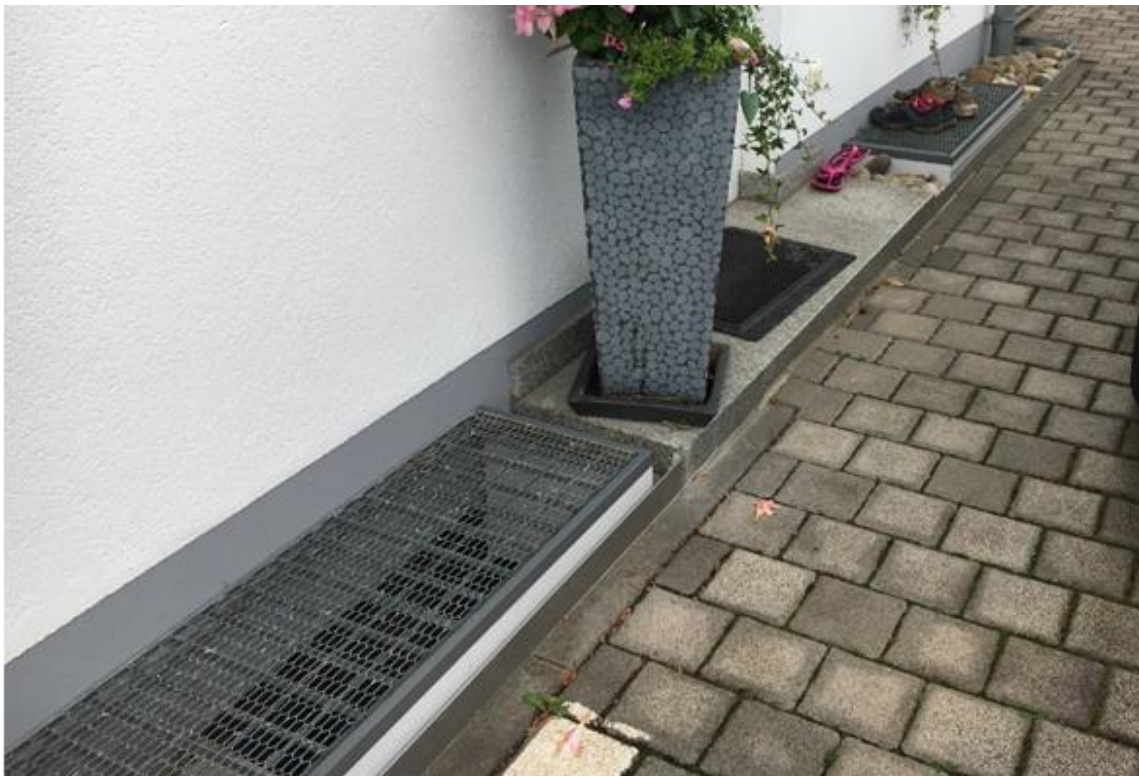
Abb. 34: Aufkantung (Edelstahlblech) an Lichtschacht
