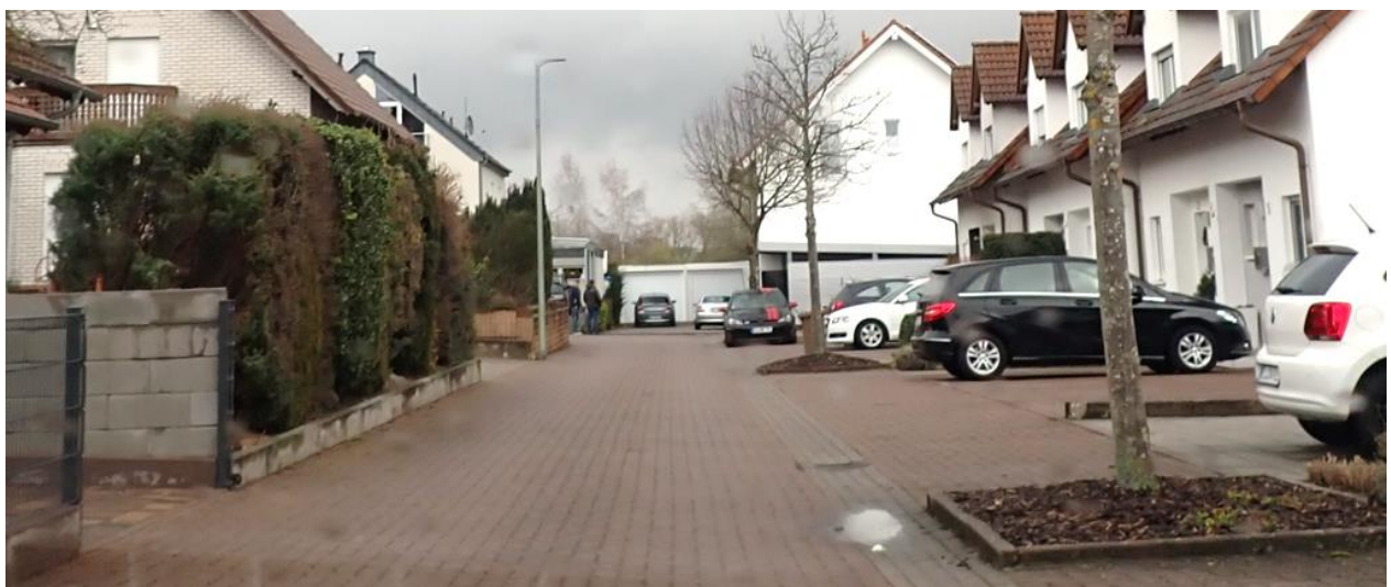
Abb. 7: Abschüssige Straße ohne Notabflussweg
