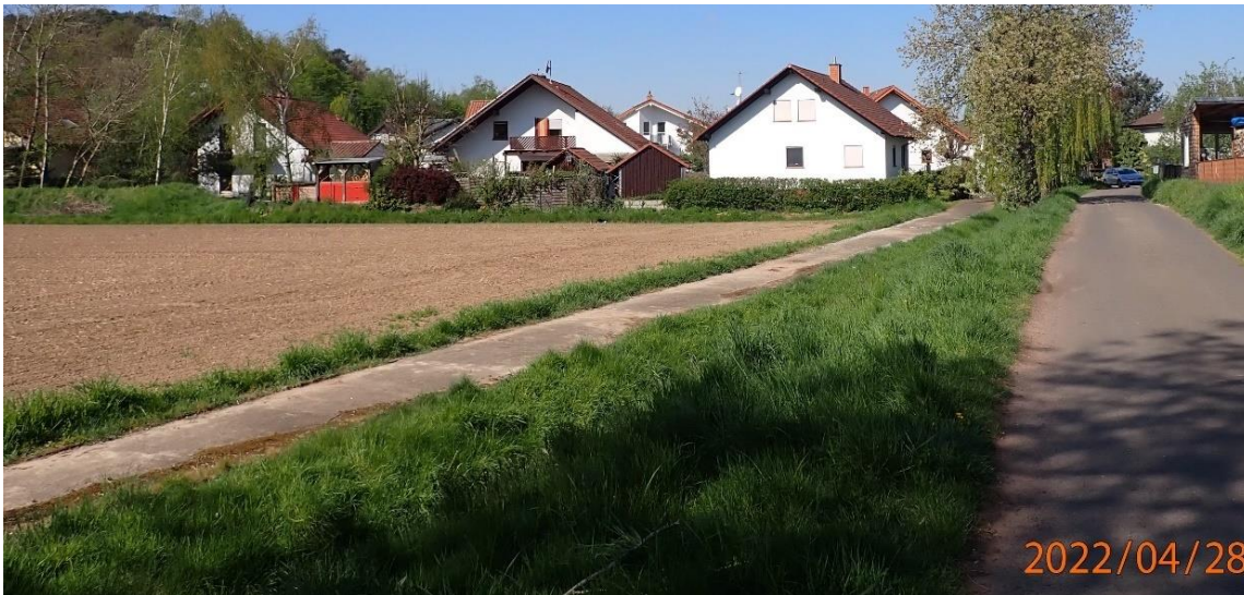
Abb. 54: Überflutungsgefährdeter Bebauungsrand in der Schorlenberger Straße
