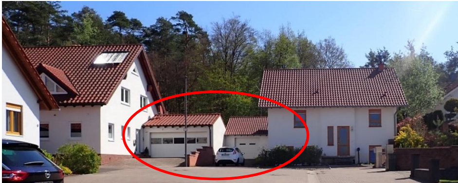
Abb. 65: Verbaute Abflusslinie am Ende der Straße „Erzkiefern“
