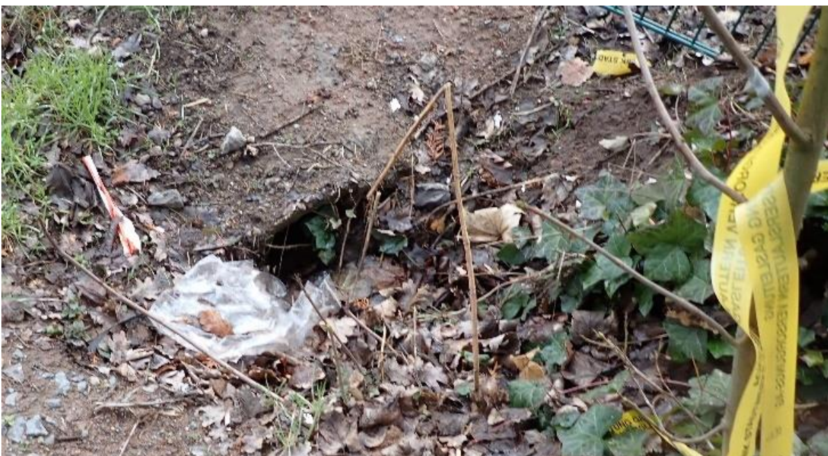
Abb. 96: Verlegtes Zulaufbauwerk zum Regenwasserkanal
