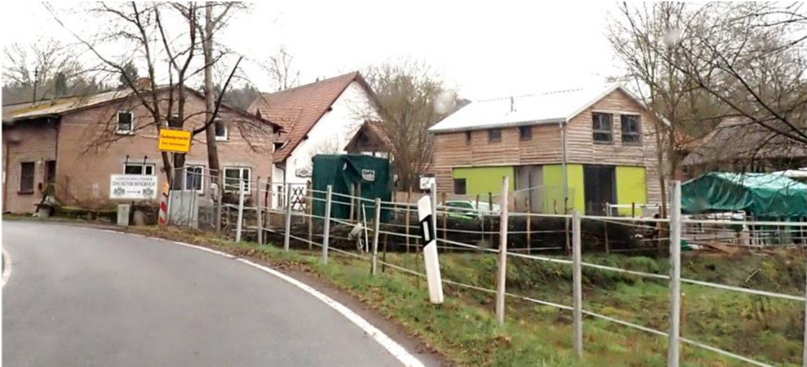
Abb. 102: Potenziell überflutungsgefährdete Gebäude in der Talsohle
