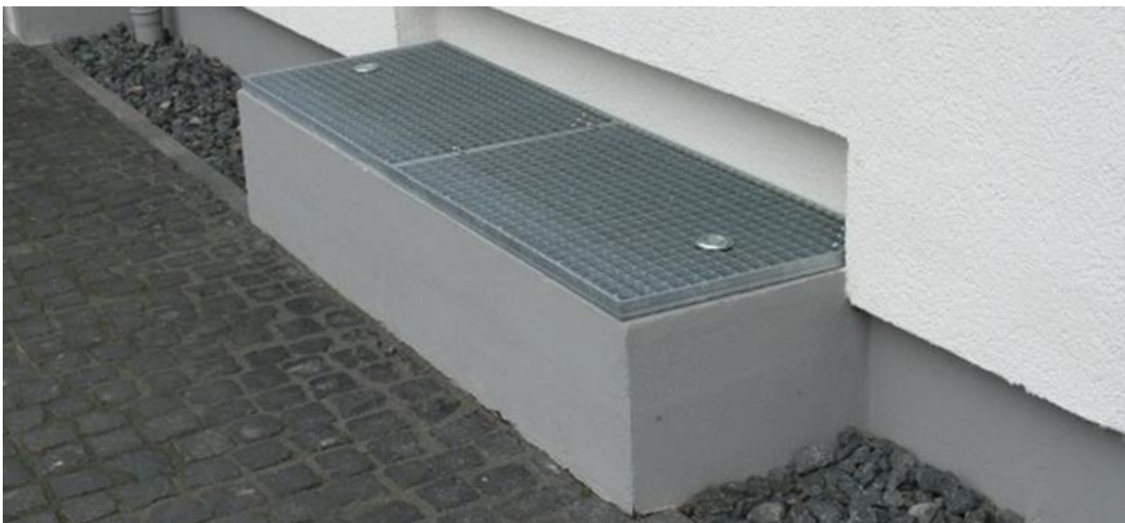
Abb. 17: Beispiel für die Sicherung eines niveaugleichen Lichtschachtes Örtliches Hochwasser- und Starkregenvorsorgekonzept OG Enkenbach-Alsenborn
