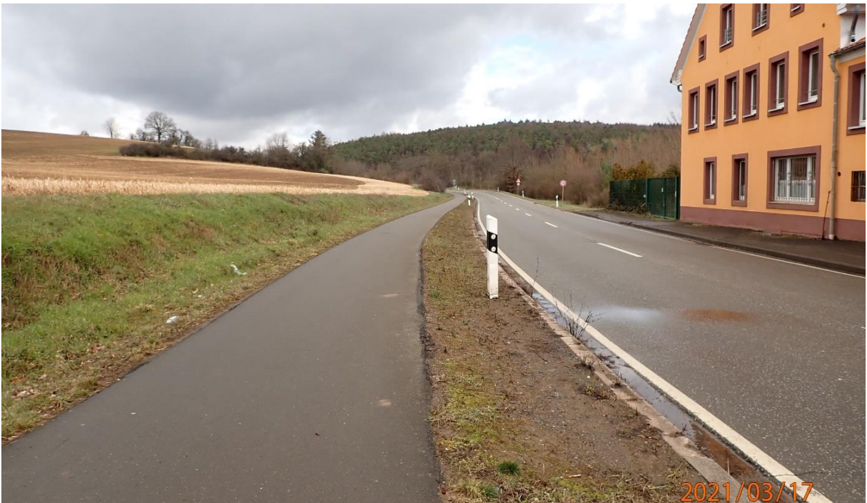
Abb. 44: B 48 mit schwach bzw. nicht ausgebildetem Seitengraben
