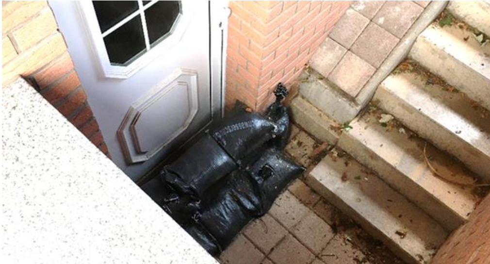
Abb. 35: Provisorischer Objektschutz im Klosterfeld
