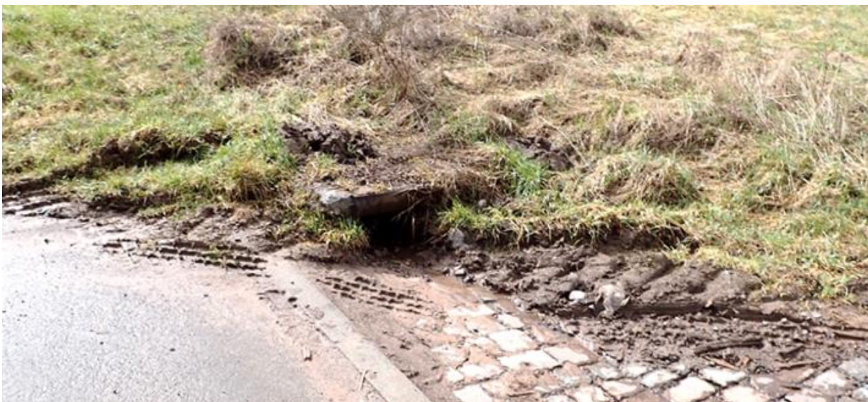
Abb. 48: Verschmutzte Querrinne an der B 48
