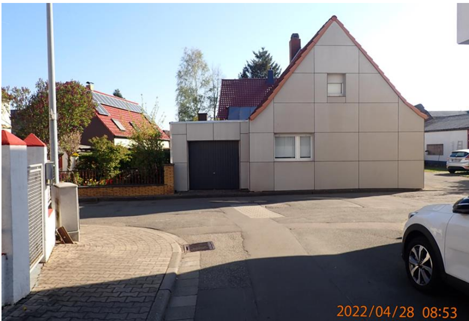
Abb. 29: Tiefpunkt der Welschgasse mit überflutungsgefährdeter Bebauung
