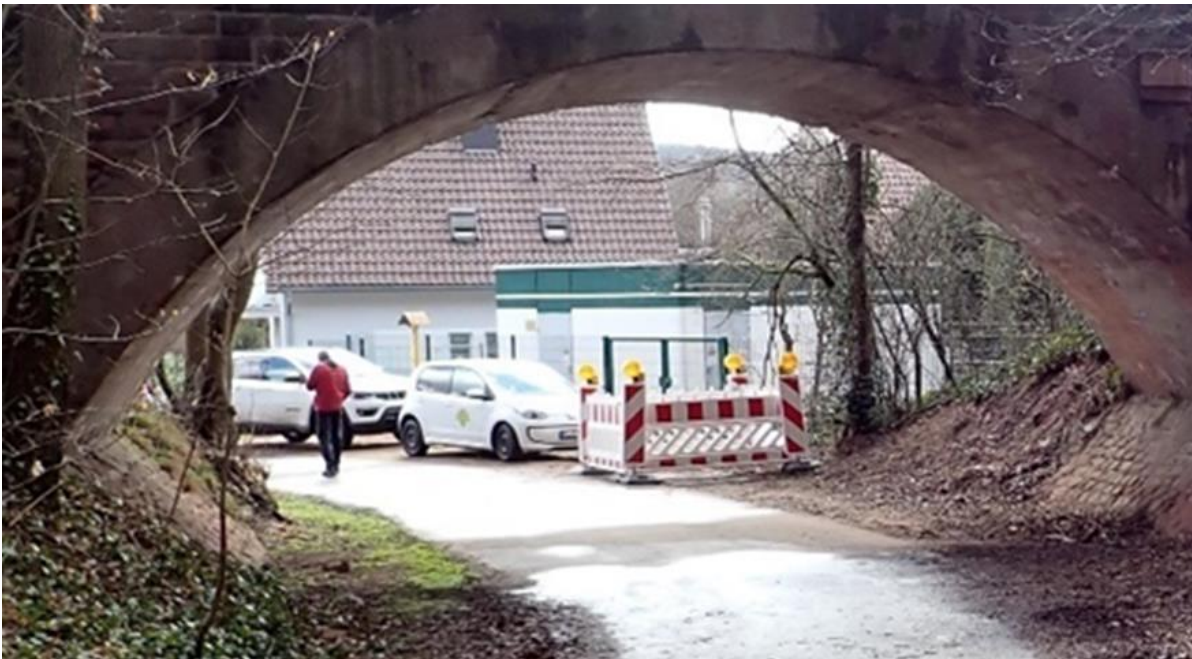
Abb. 95: Übergang des Waldwegs auf die Sonnhofstraße
