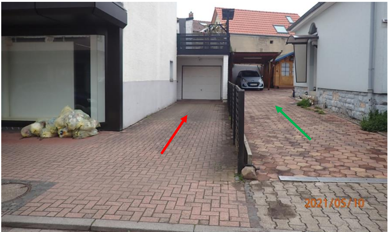
Abb. 16: Überflutungsfördernde (rot) und überflutungsangepasste Bauweise (grün)
