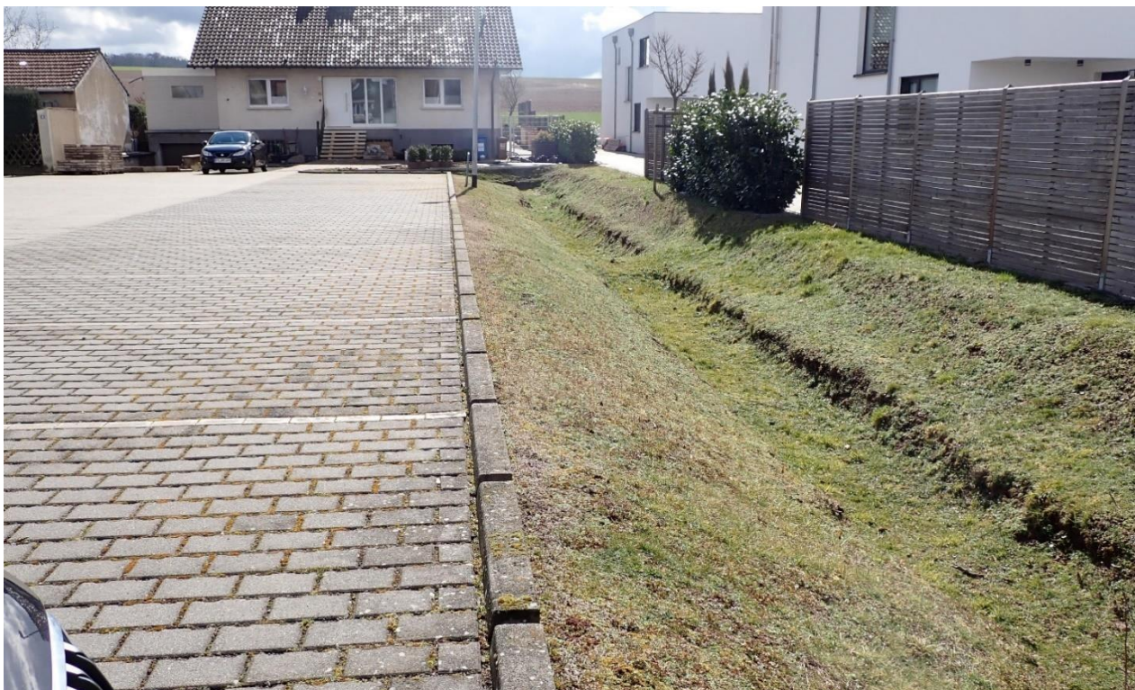
Abb. 85: Sickermulde zwischen Parkplatz und Anliegerstraße
