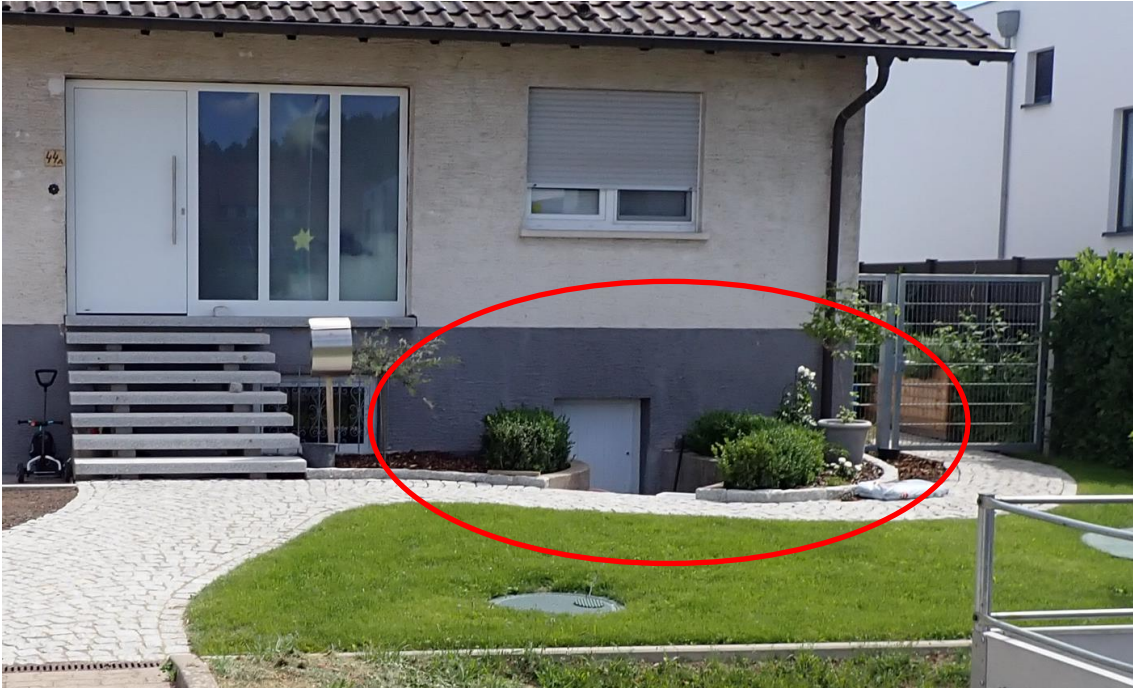
Abb. 13: Untergeschoss mit außenliegendem Zugang
