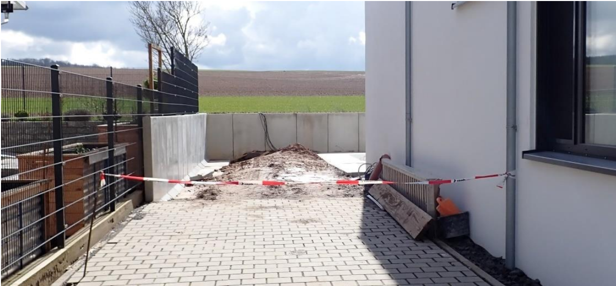
Abb. 82: Neue Randbebauung mit Einfriedungsmauer über dem Gelände
