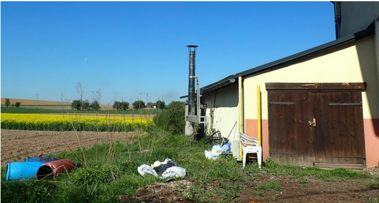
Abb. 72: Überflutungsgefährdeter Bebauungsrand der Herlenbergstraße
