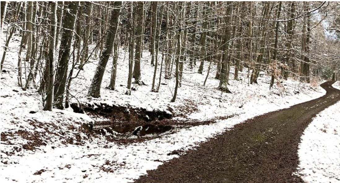
Abb. 10: Kleinrückhalt als Sickermulde neben einem Waldweg
