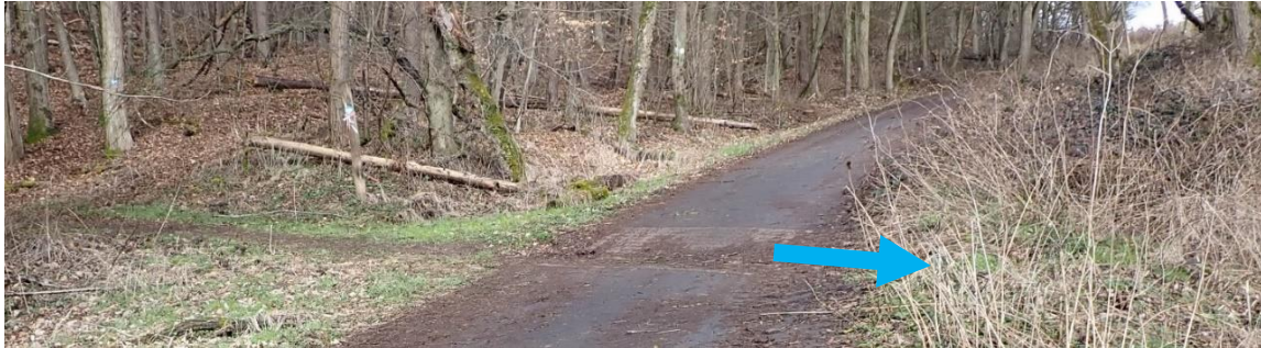
Abb. 92: Querschlag in Mulde (Kleinrückhalt) neben dem Weg
