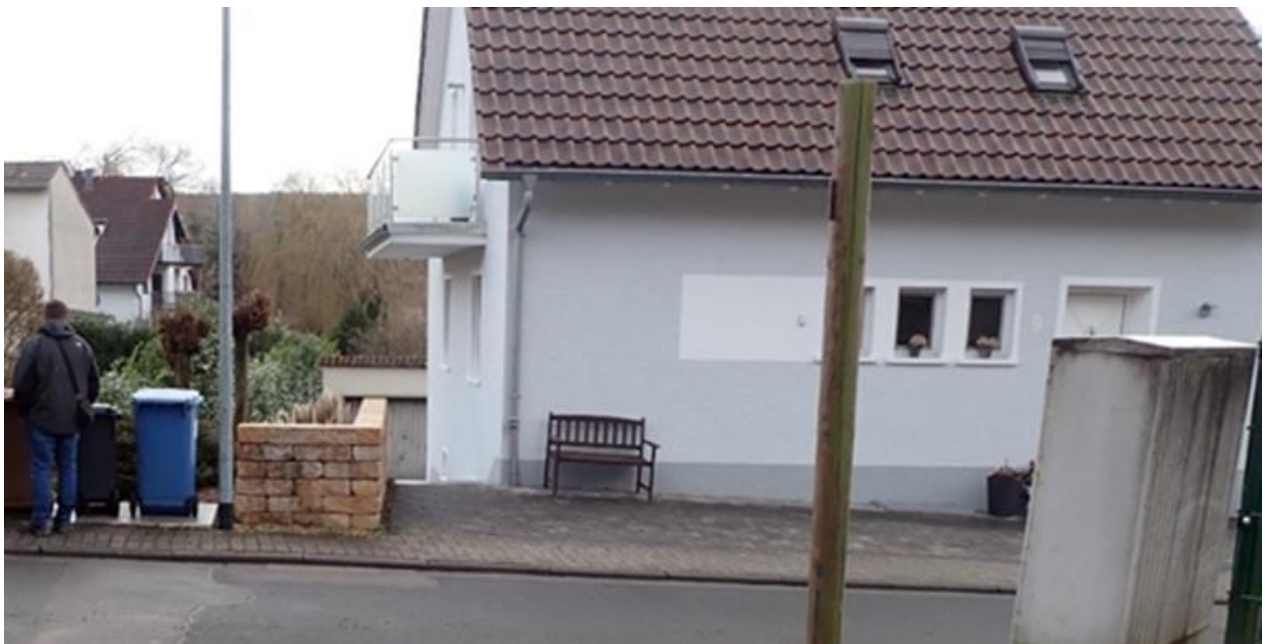
Abb. 98: Überflutungsgefährdetes Haus in der Abflusslinie
