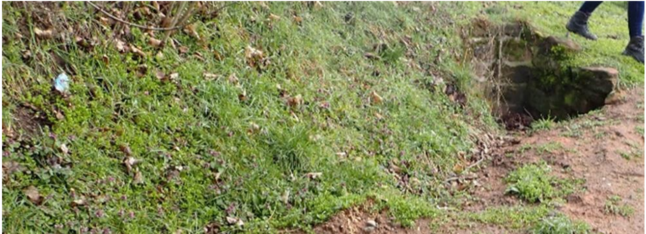
Abb. 97: Nicht angeströmtes Zulaufbauwerk zum Regenwasserkanal
