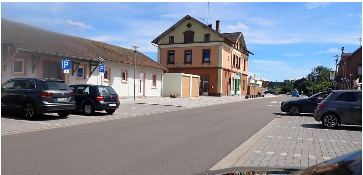
Abb. 41: Potenziell überflutungsgefährdete Bebauung in der Bahnhofstraße
