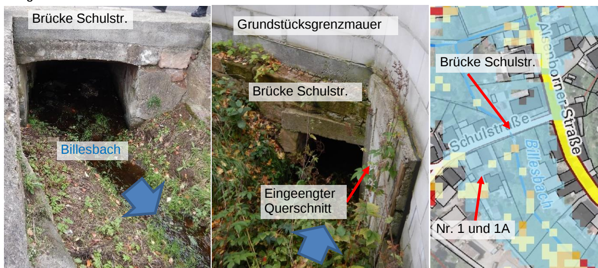
Abbildung 28 Situation Brücke Schulstraße über Billesbach
