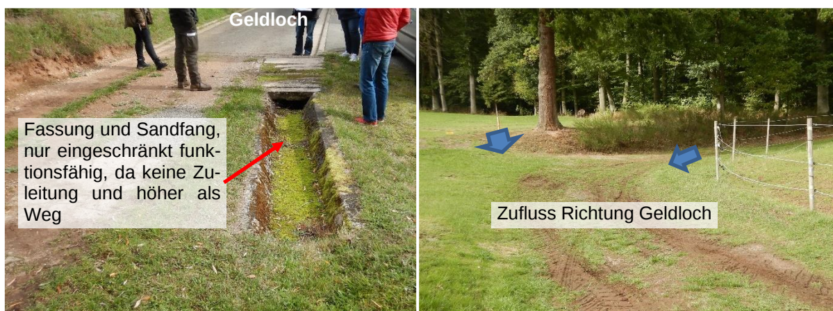
Abbildung 39 Situation Beginn Bebauung Geldloch
