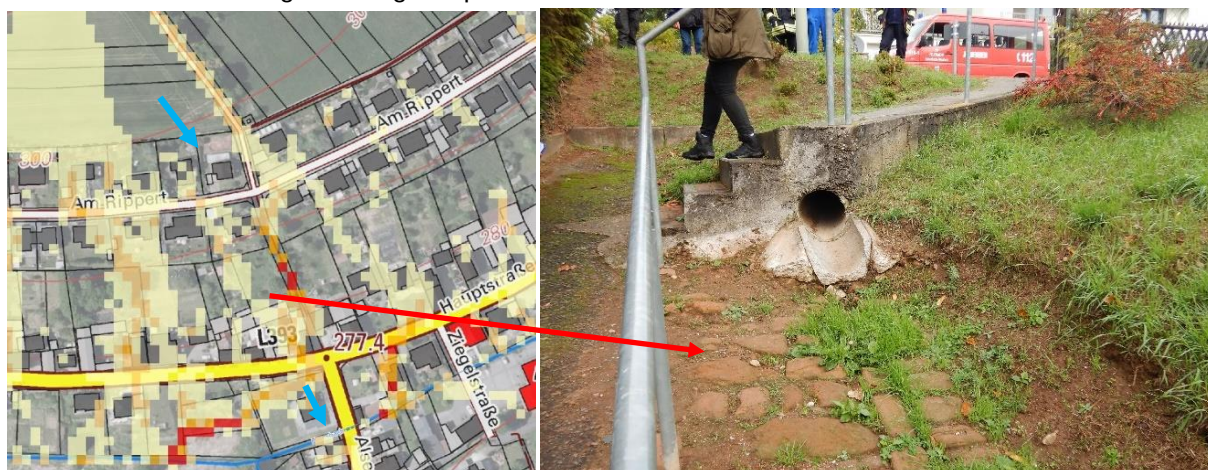
Abbildung 27 Starkregenabfluss im Bereich des Fußweges zur Hauptstraße
