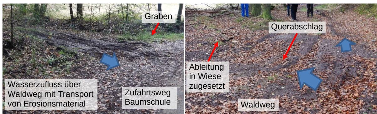
Abbildung 17 Situation Wirtschaftsweg an der Baumschule zur L394
