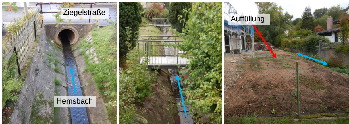
Abbildung 19 Situation Hemsbach im Bereich der Ziegelstraße
