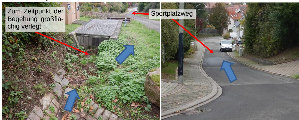
Abbildung 31 Situation Einlaufbauwerk mit Sandfang am Sportplatzweg
