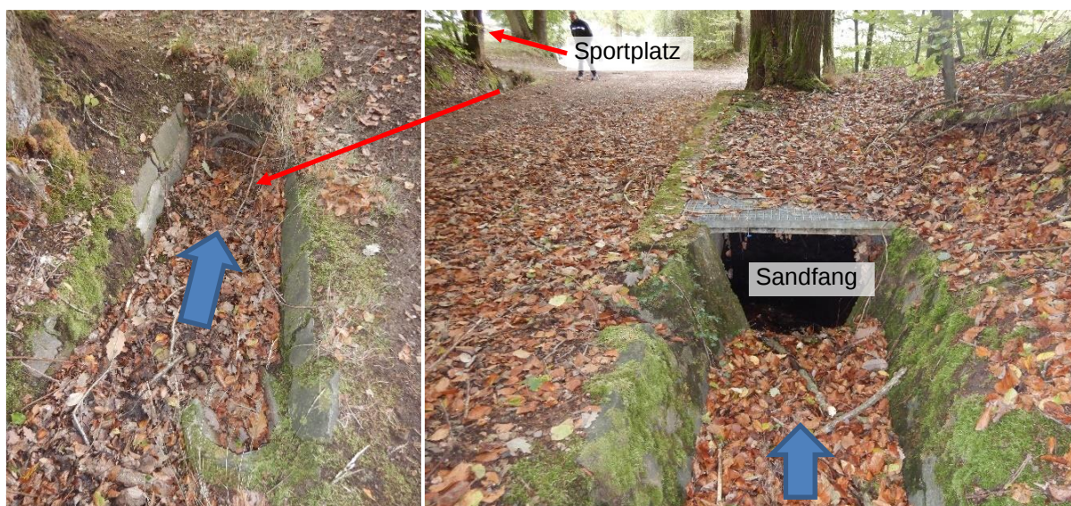
Abbildung 30 Situation Wasserefassung Waldweg oberhalb des Sportplatzes
