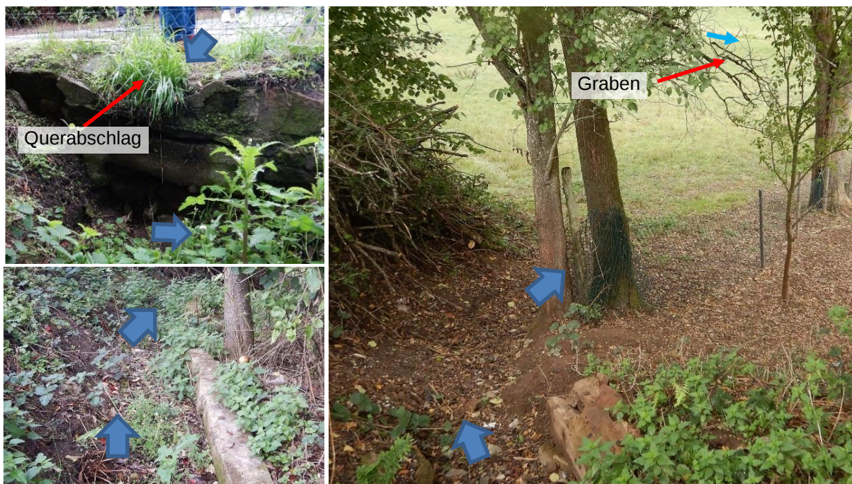
Abbildung 25 Situation am östlichen Wirtschaftsweg oberhalb von Am Rippert
