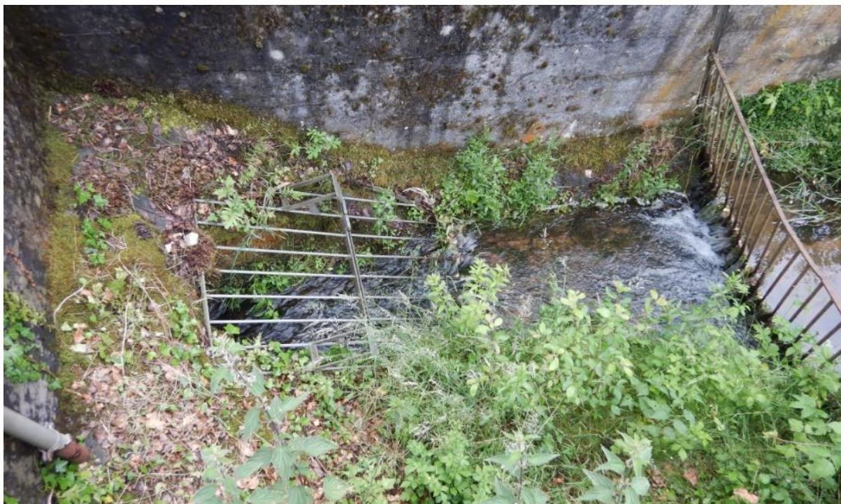
Abbildung 10 Einlauf Verrohrung Glasbach im Bereich Villa Denis
