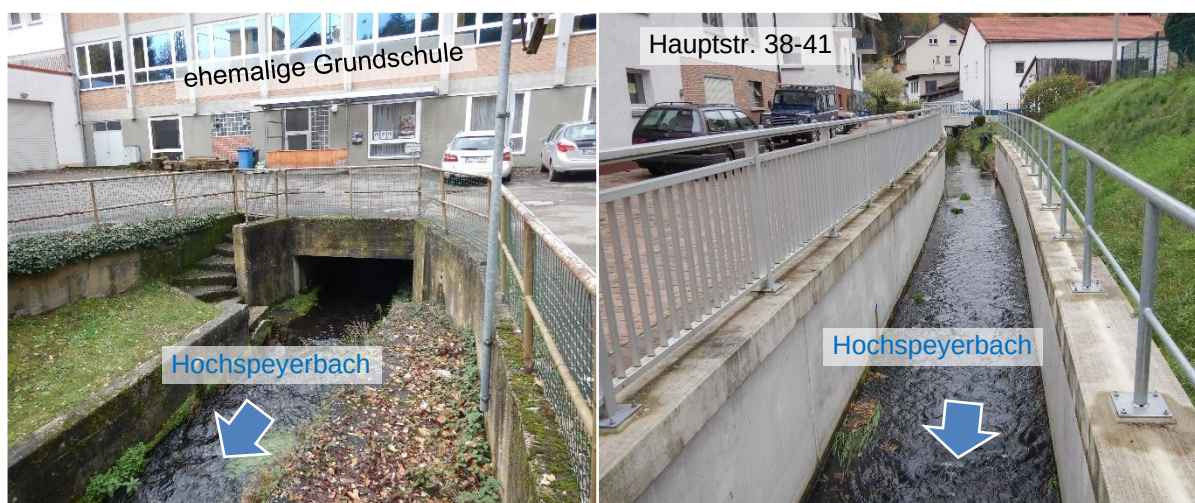
Abbildung 25 Situation Hochspeyerbach Bereich ehemalige Grundschule
