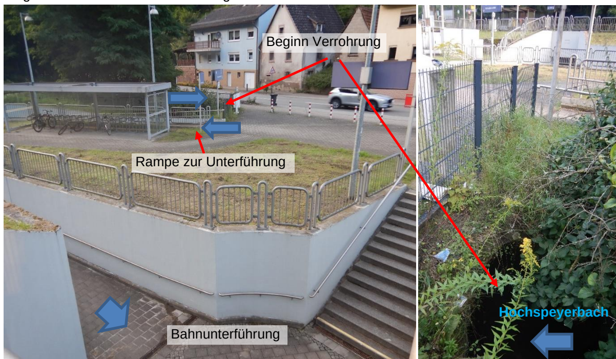
Abbildung 20 Beginn Bachverrohrung Hochspeyerbach vor Bahnhof, Unterführung
