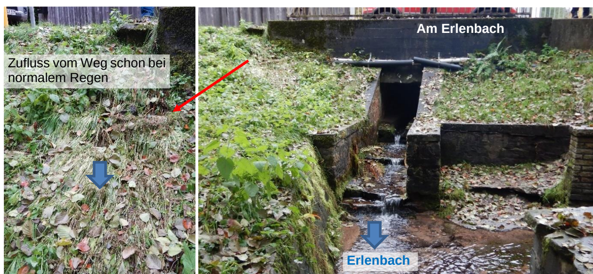
Abbildung 35 Situation Verrohrung Erlenbach Kistenfabrik (Am Erlenbach 33)
