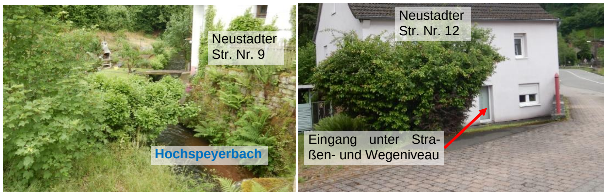
Abbildung 48 Situation Neustadter Straße Nr. 9 und 12
