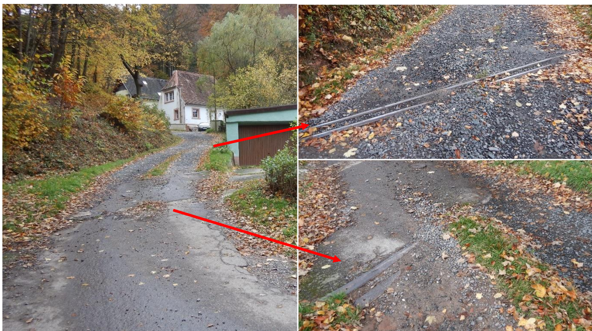
Abbildung 44 Spechtental Situation Zufahrt, nicht funktionsfähige Querabschläge
