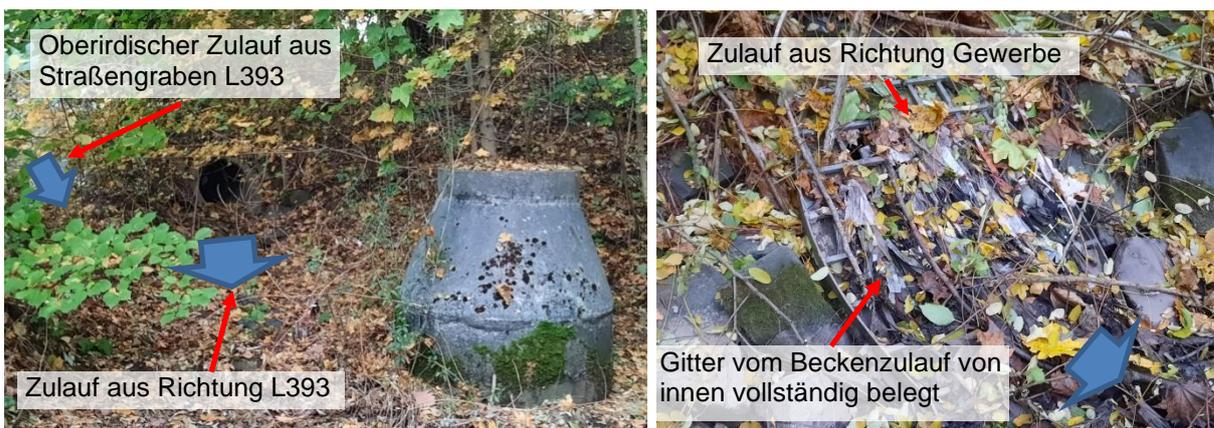
Abbildung 11 Zulaufsituation östliches Becken an der L393
