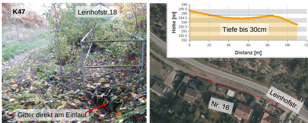
Abbildung 25 Situation Außengebietswasserfassung und Senke Leinhofstr.
