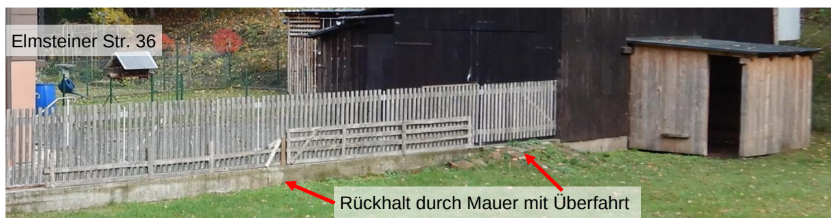
Abbildung 16 Objektschutz Elmsteiner Str. 36 / Rückhalt vor Bebauung
