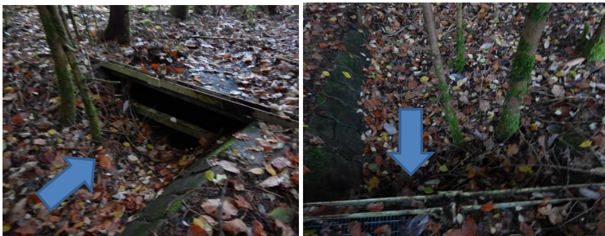
Abbildung 12 Außengebietswasserfassung am Wirtschaftsweg bei der Feuerwehr
