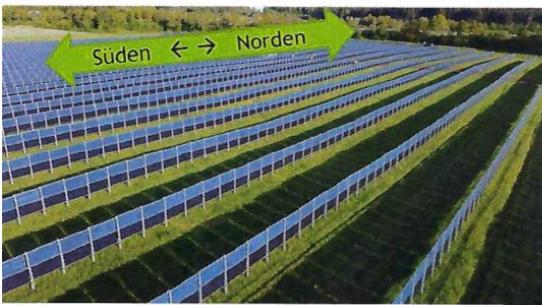
Fig. 2: Agri-PV mit vertikalen Modulen
