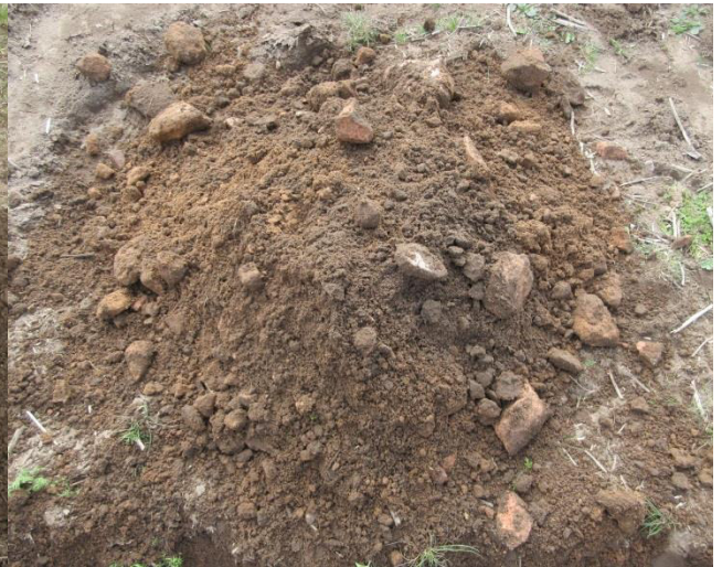
Handschurf 2: Aushub Sohle: Buntsandsteinfels
